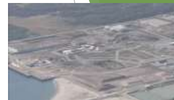
東通原子力発電所（東京電力）
