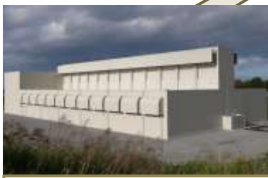
使用済み燃料中間貯蔵施設
