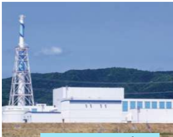
原子力発電所
