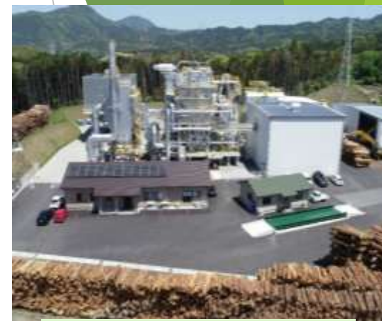
バイオマス発電所
