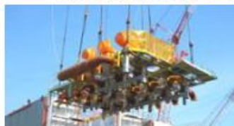
ABWRの高圧ドレンポンプ 配管・弁室モジュール
