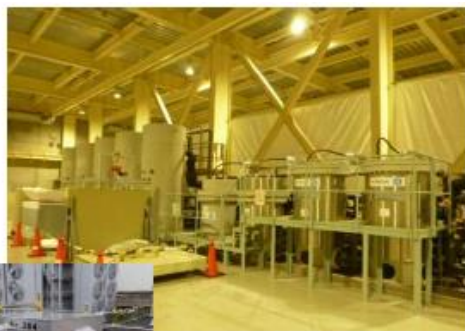
サブドレン処理
