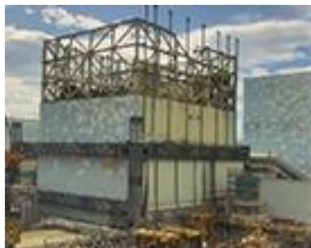
ガレキ除去, 実施中
