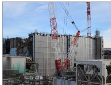
使用済燃料取り出し用カバー, 設置工事中
