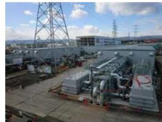
冷凍プラント建屋
