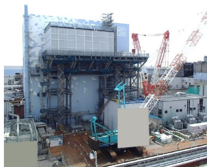
構台設置, 完了
