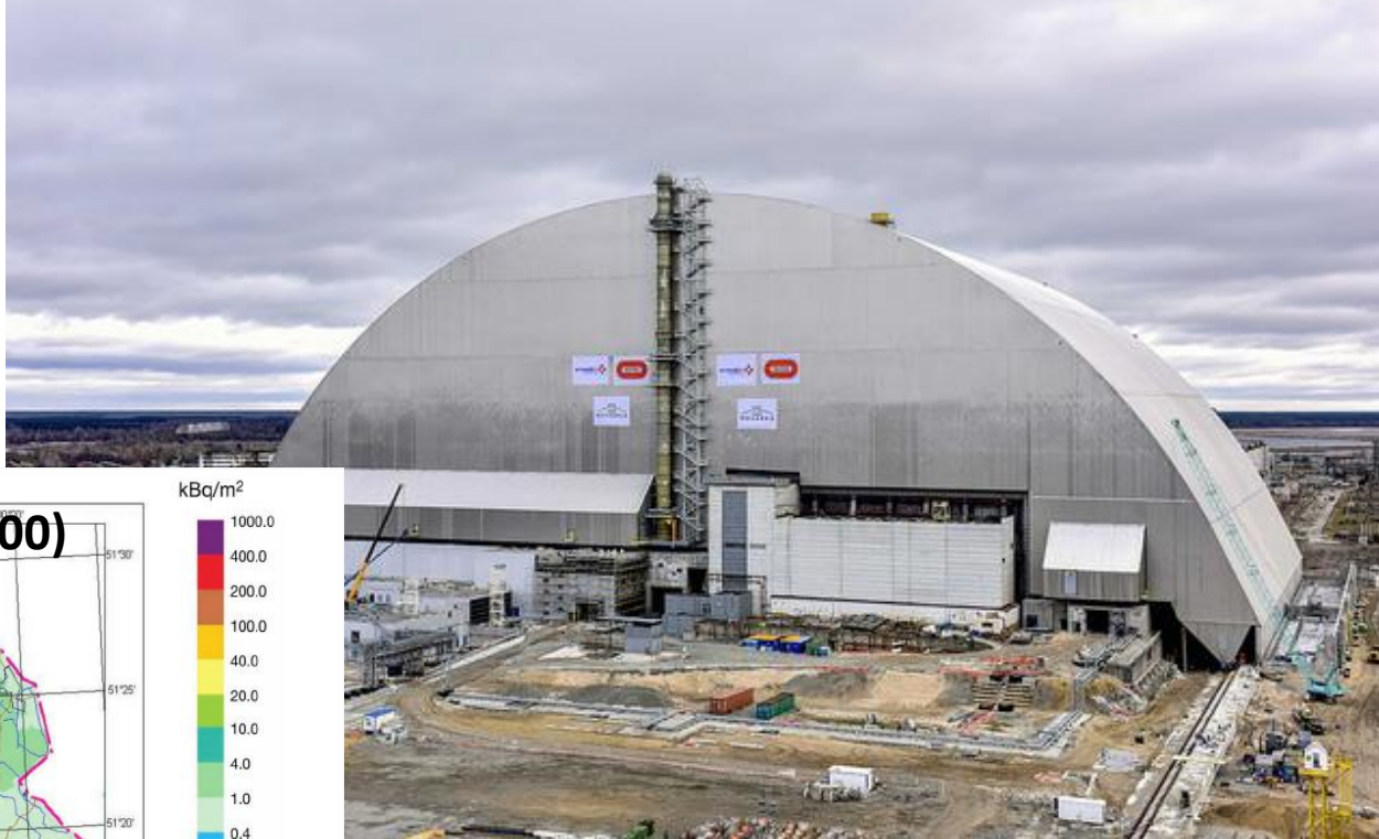
新設された閉じ込めシェルター
