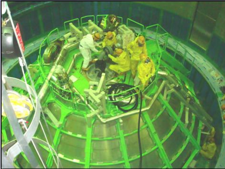
小径配管切り離し中
