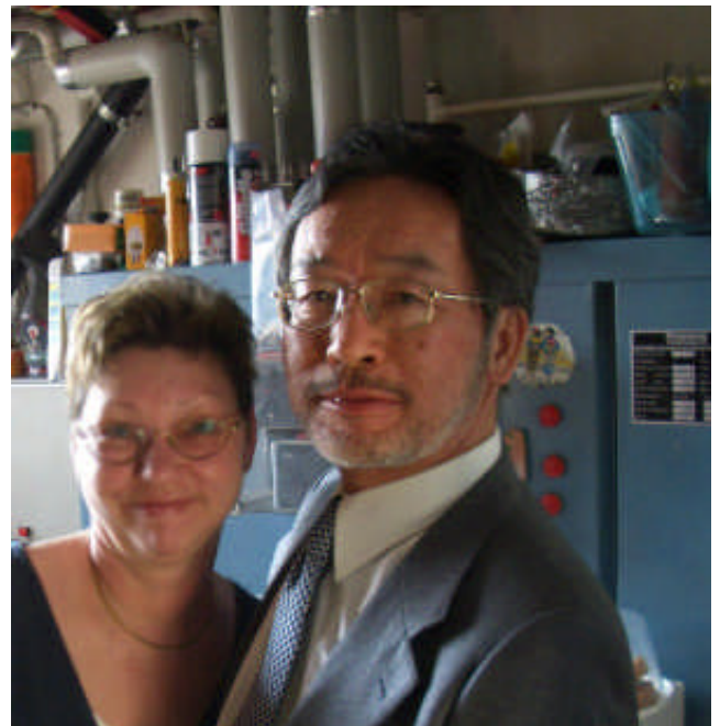
スイスのレストランのオーナーと業務用ボイラーの前で（ボイラーの加熱源はベツナウ原子力発電所からの高温加圧水です。）
