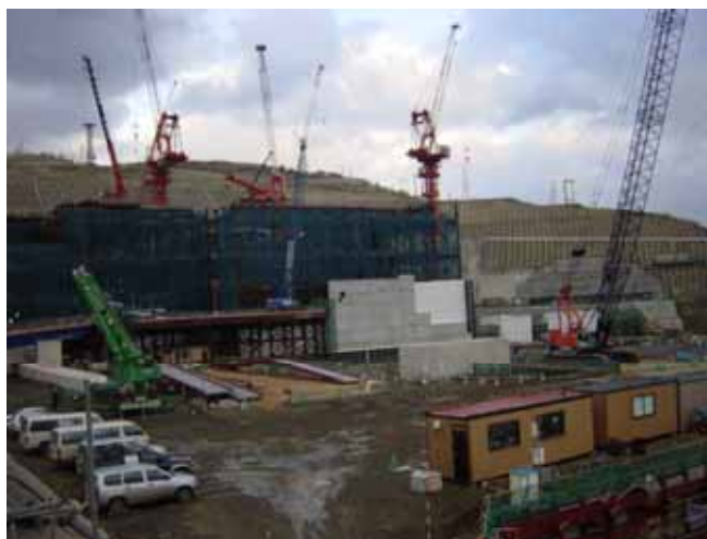
泊 3 号機建設現場
