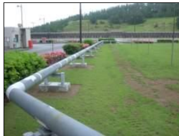
消火配管の地上化
