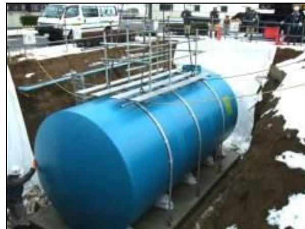
耐震防火水槽設置
