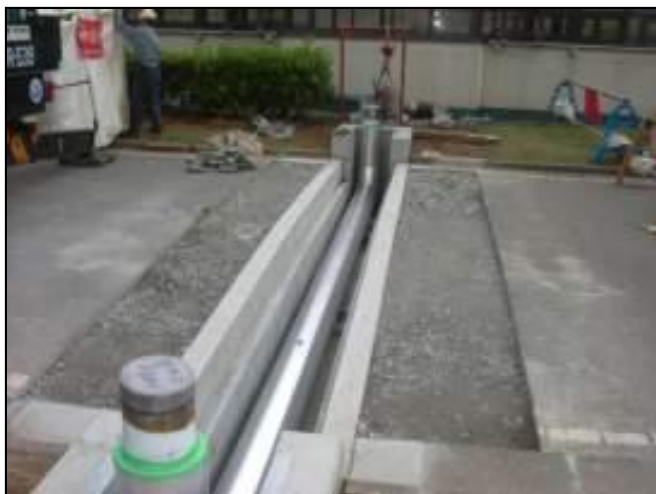
消火配管のトレンチ化
