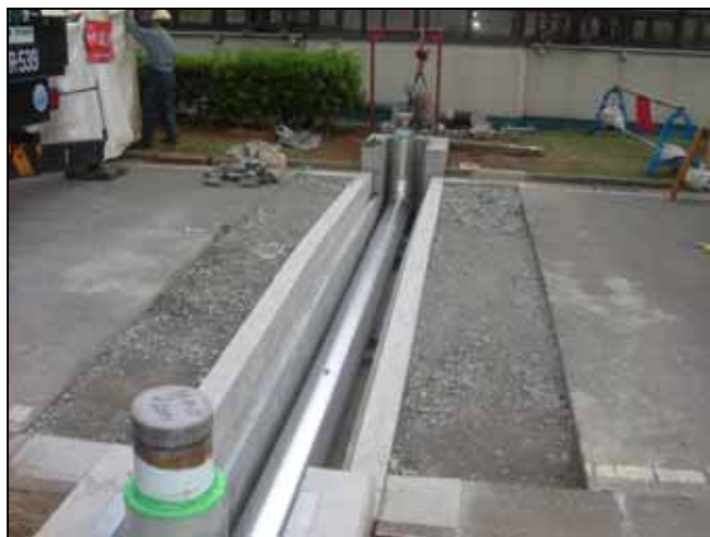
消火配管のトレンチ化
