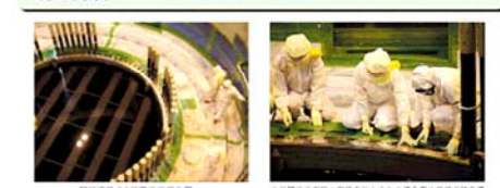
新設された2号機炉内点検用通路 2号機炉内点検用通路とみた2号機炉内点検の様子
