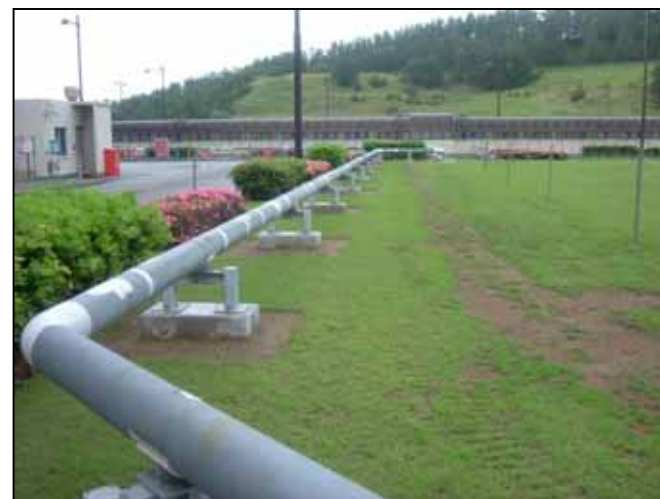
消火配管の地上化
