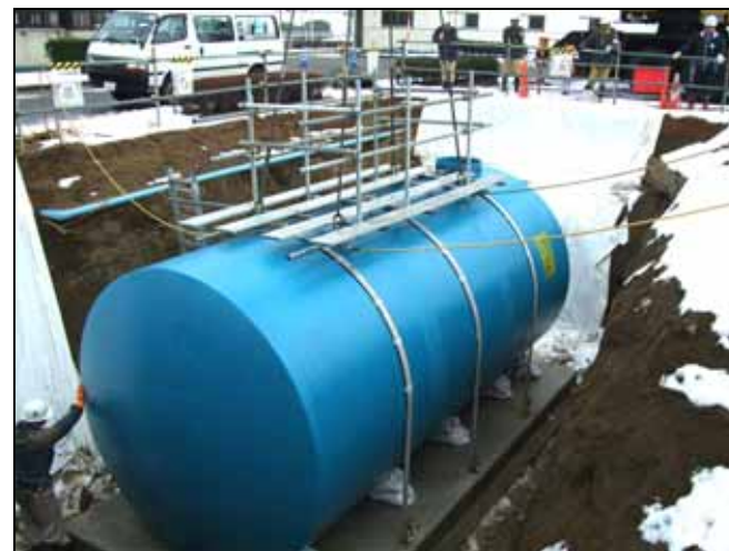
耐震防火水槽設置
