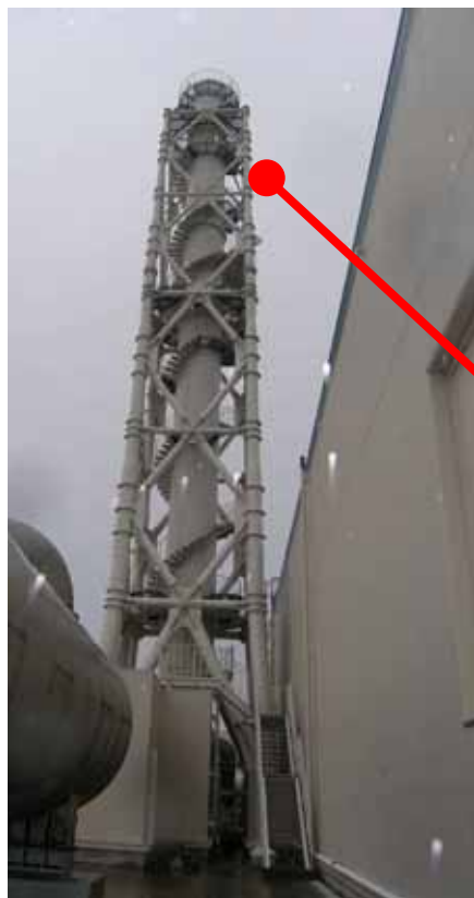
主排気筒の 支持構造物の追設
