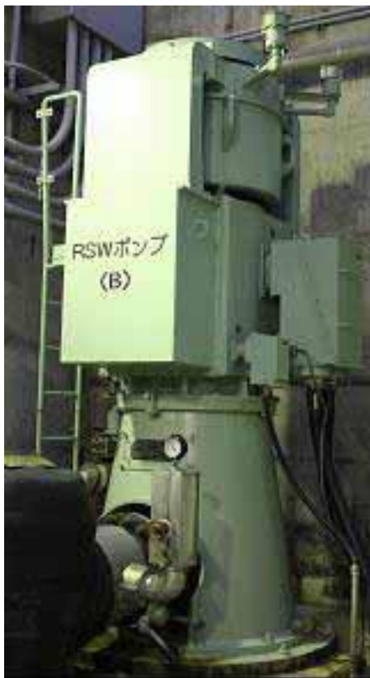
原子炉補機冷却 海水ポンプ用電動機 (設置された状態)
