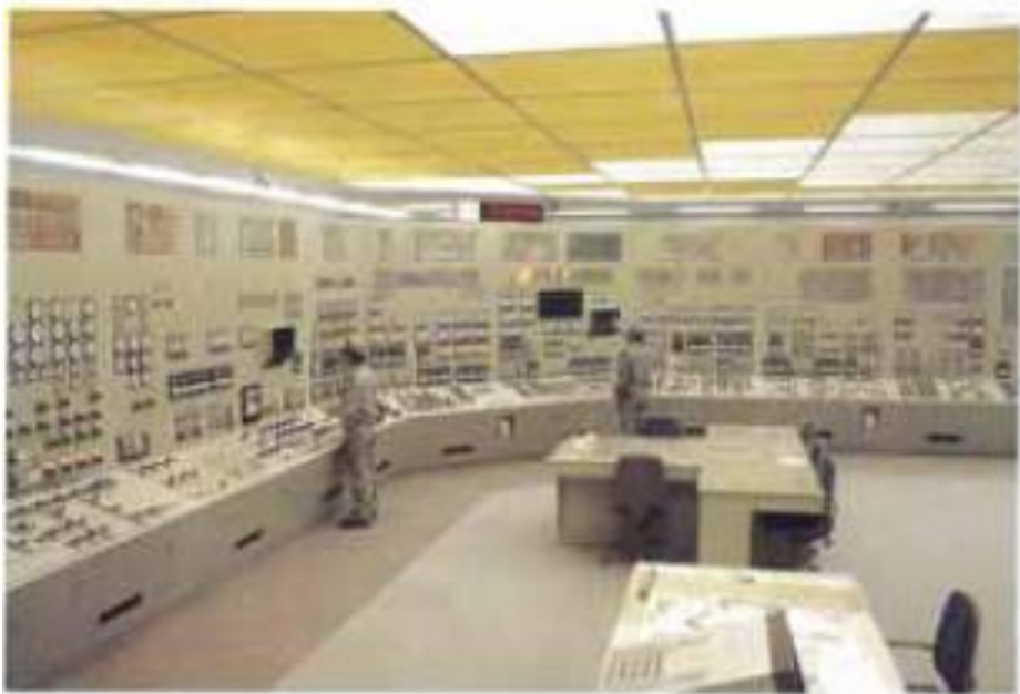
全交流電源喪失時の運転操作対応訓練
