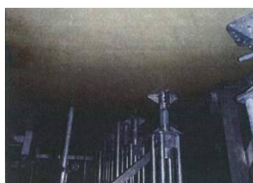
鋼製支柱設置状況 (ジャッキ部)
