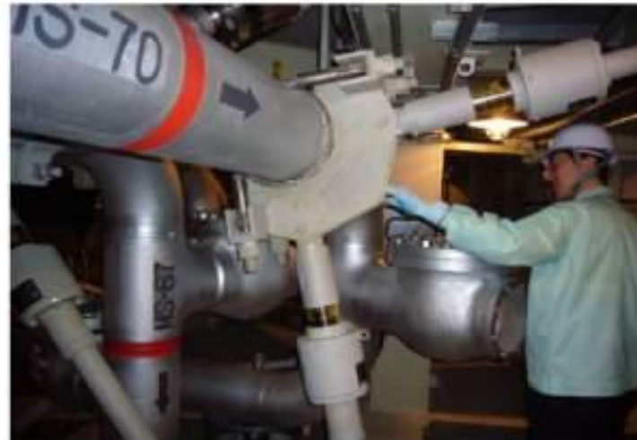
主蒸気逃がし安全弁排気管のスナッパーによる耐震補強(東京電力殿撮影)
