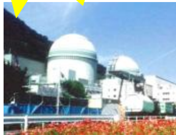
原子力発電所
