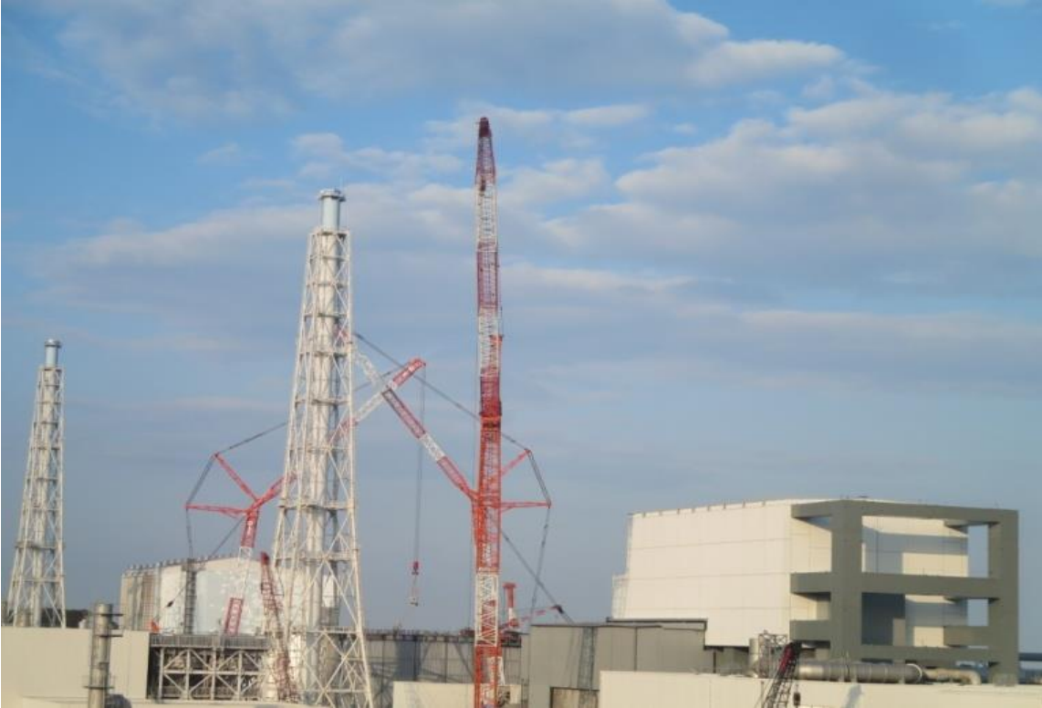
山側から見た左から 2 号機、 4 号機の上 部（間の 3 号機はオペフロが削られていてよく見えない）
