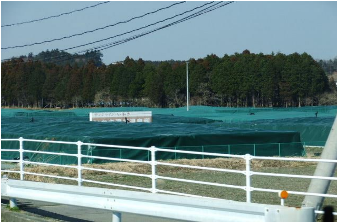
除染のためはぎ取った土の中間保管場（青色のシートで覆ってある）
