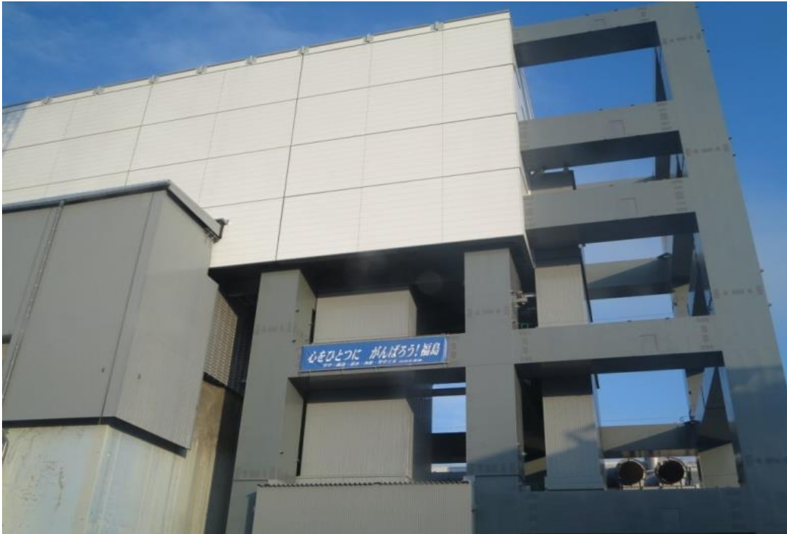
4号機使用済燃料キャスク吊り降し部（見えないが手前下部が搬出口）
