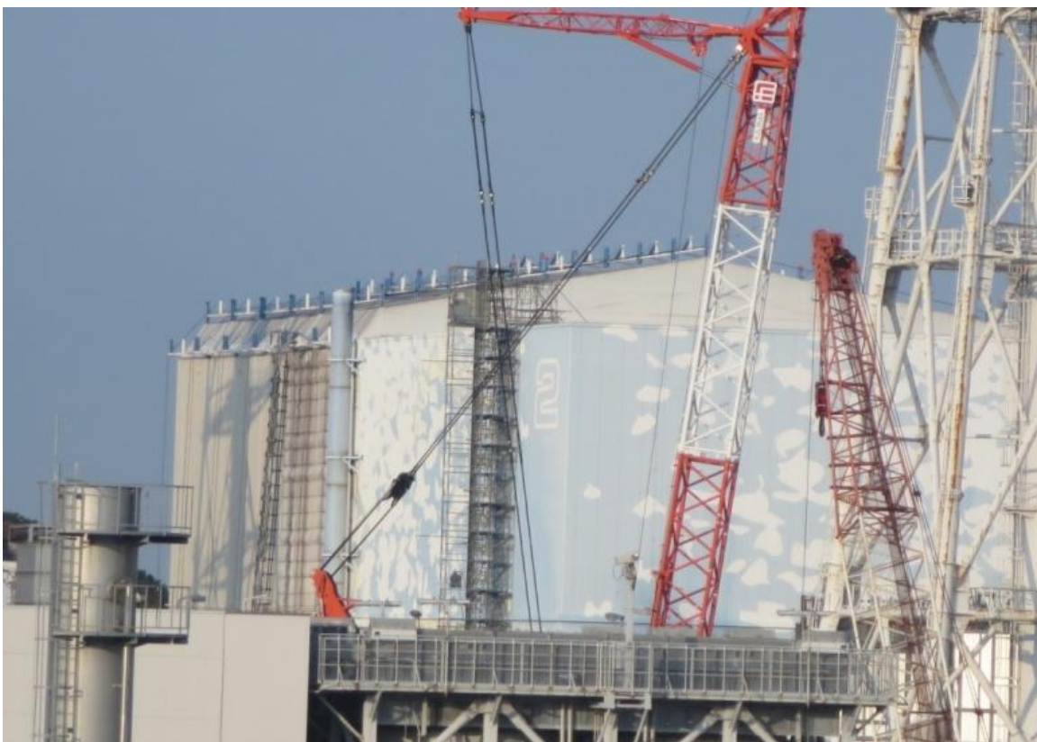
奥：カバーで覆われた1号機の一部 手前：水素爆発を免れた2号機建屋
