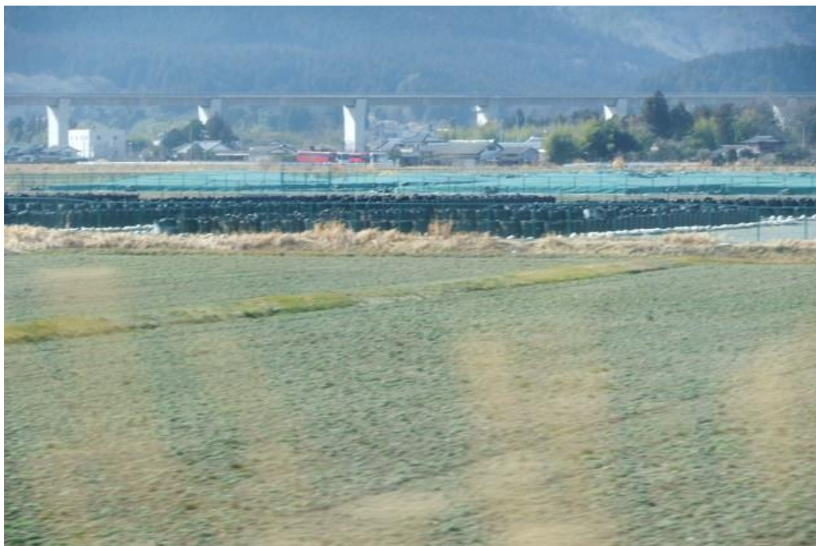
建設中の常磐高速道（富岡—大熊）
