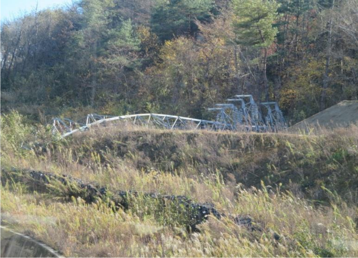
地震のために倒壊した外部電源用鉄塔
