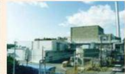
解体中の原子力施設
