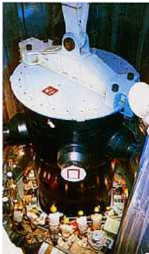
据付け中の原子炉 压力容器
