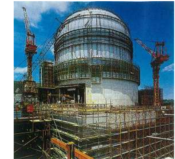
据付中の原子炉格納容器
