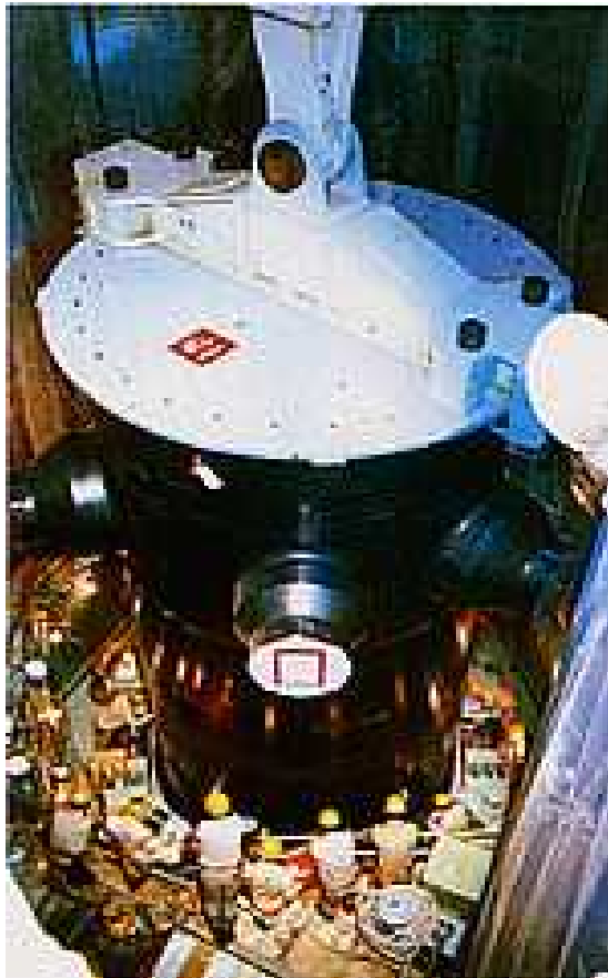
据付け中の原子炉 压力容器
