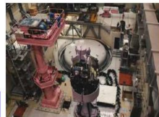
HTTRの外観および内部
