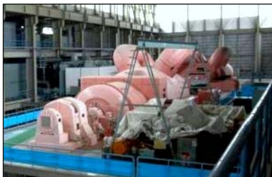
撤去前のタービン発電機
