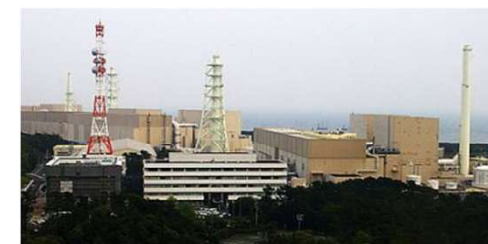
浜岡原子力発電所.
