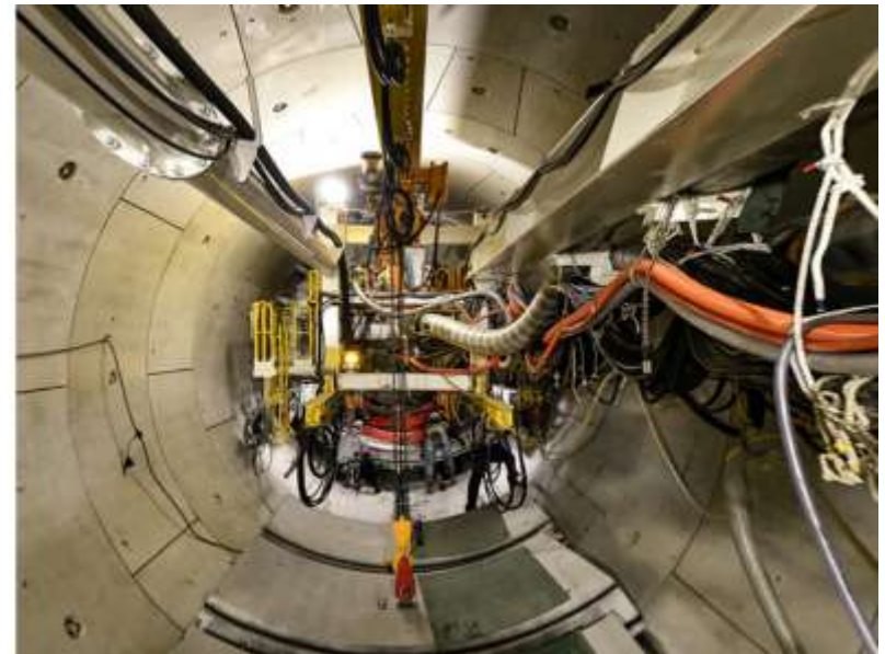
シールドマシンで掘削する洞道新設工事
