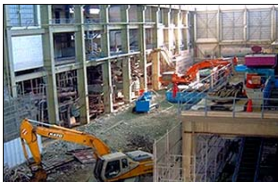
タービン建屋内構造物撤去
