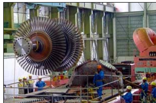
タービン発電機の撤去
