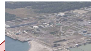
東通原子力発電所（東京電力）
