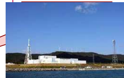
東通原子力発電所（東北電力）
