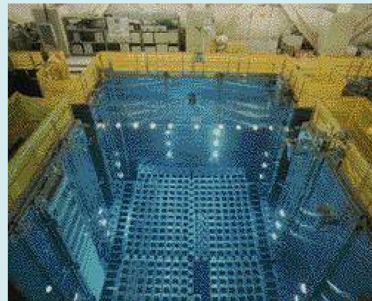
使用済み燃料保管(北海道電力HP)
