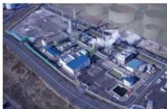
CO2分離・回収・貯留施設
