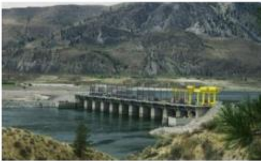
水力による水素製造施設
