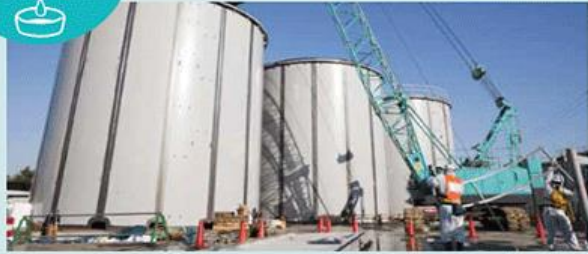
フランジ型から溶接型のタンクへ変更
