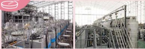
多核種除去設備 (ALPS)
