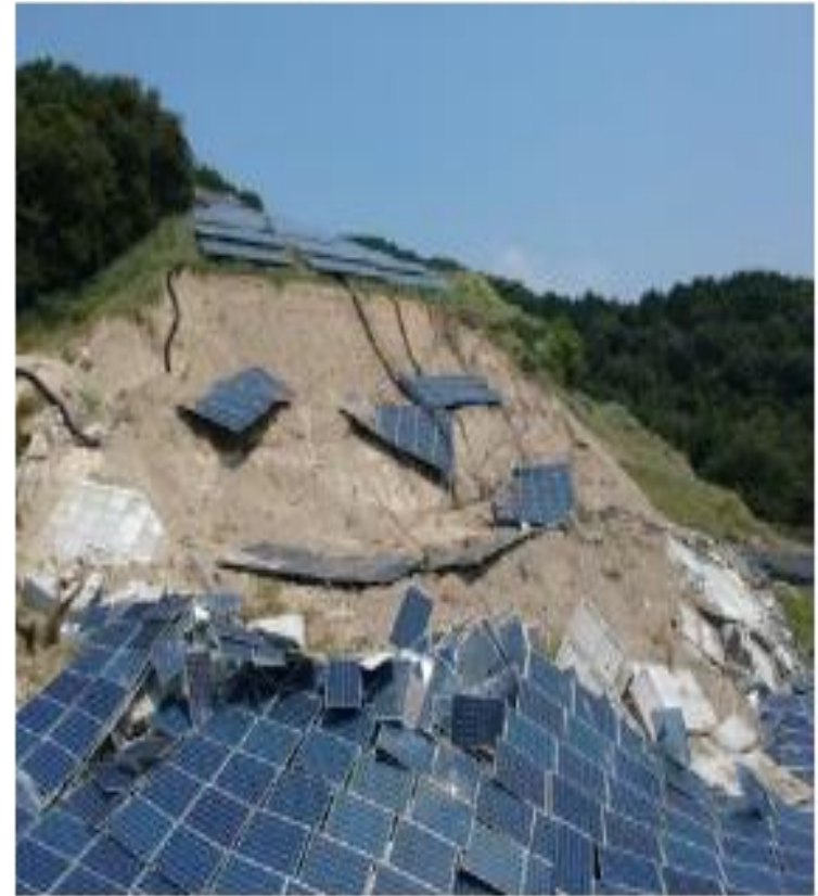
豪雨災害による太陽光発電設備の被害例
