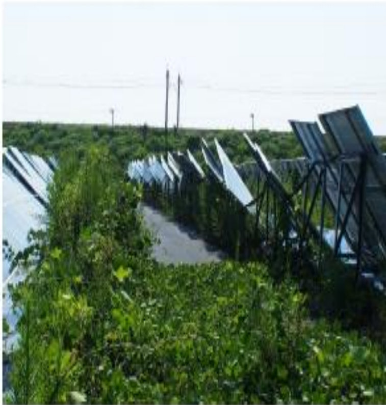
適正に管理されていない太陽光発電設備の例
