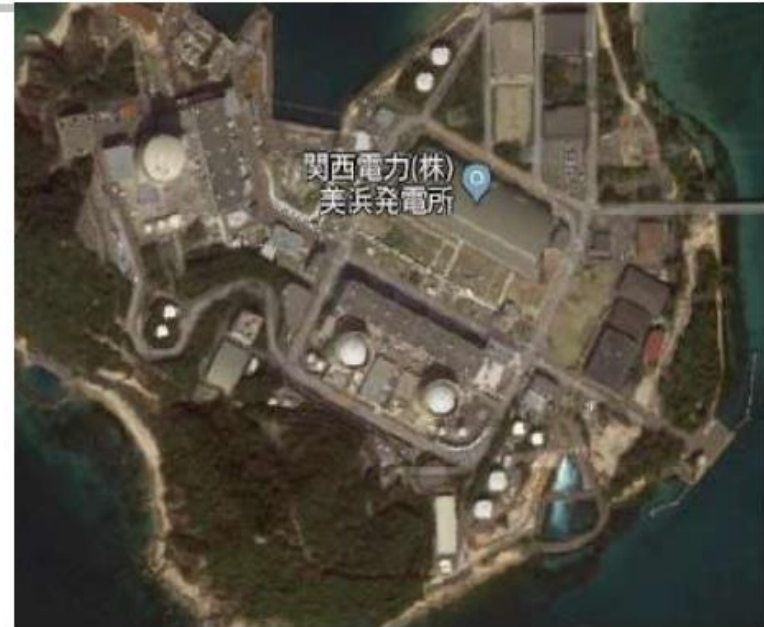
美浜原子力発電所 福井県三方郡美浜町丹生 1号機 340 MWe ・2号機500 MWe 廃炉決定 3号機 826 MWe
