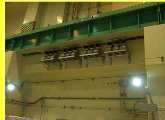
SAで発生した水素を処理する触媒装置
