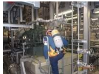
原子炉隔離時冷却ポンプの 手動操作
