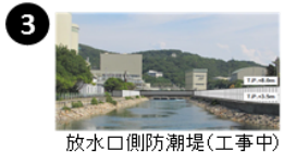
放水口側防潮堤(工事中)
