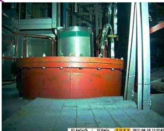
南東S/Cマンホール
