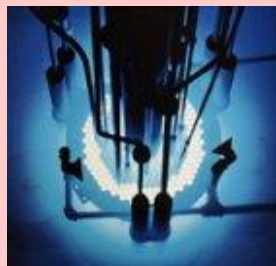
原子炉安全性研究炉 (NSRR)
