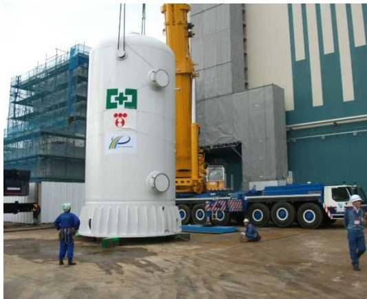
フィルタベント容器の搬入 (柏崎刈羽原子力発電所)
