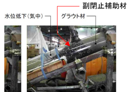
図1 ベント管止水用副閉止補助材止水試験状況
