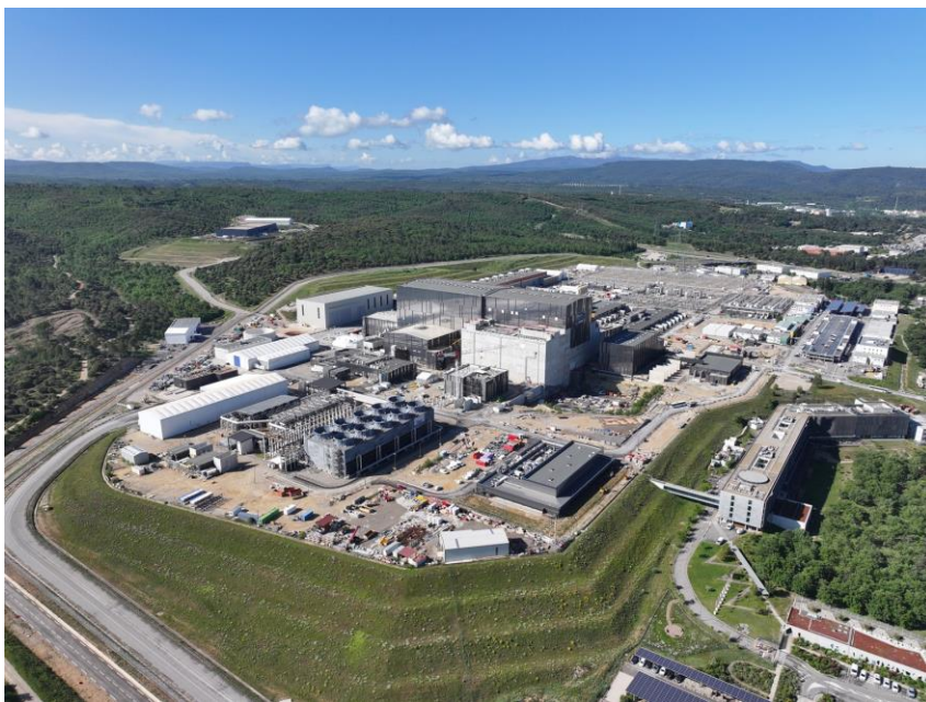
ITERサイトの建設状況（2025年5月時点）
