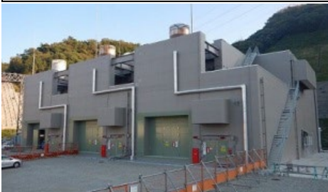
ガスタービン発電機建物 外観
