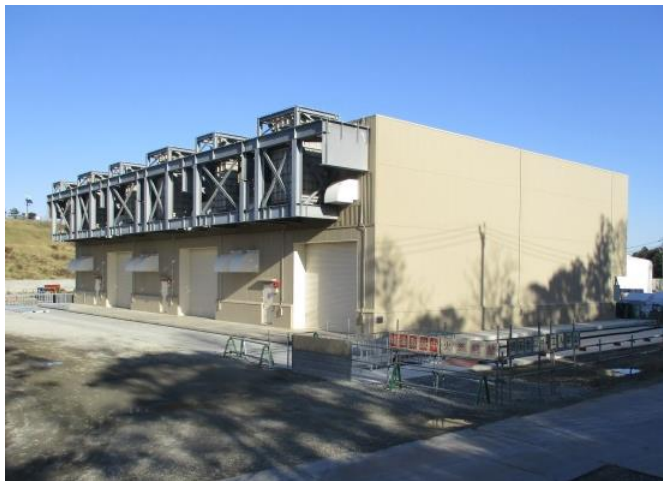
緊急時ガスタービン発電機建屋
