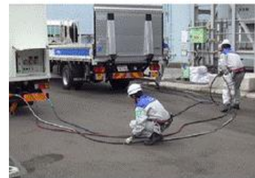
電力の供給訓練
