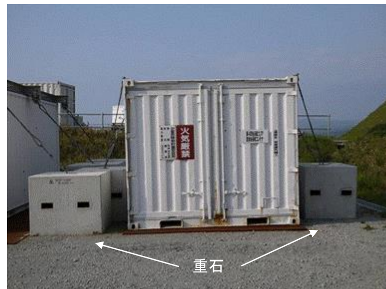
コンテナの飛散防止対策
