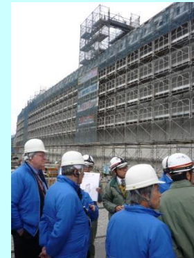
浜岡原子力発電所視察 (防波壁前にて)
