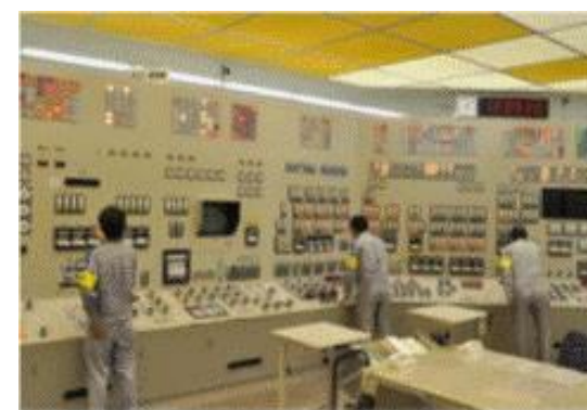
緊急時の運転操作訓練
