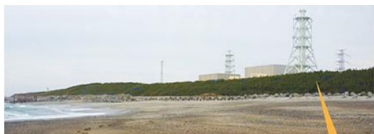
砂丘堤防：海拔10～15m、幅約60～80m、長さ約1.5km
