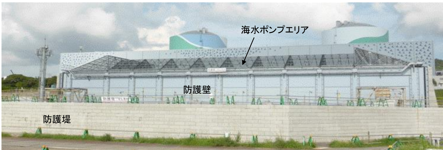
海水ポンプエリアの防水対策の概観
