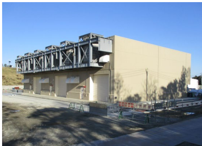
緊急時ガスタービン発電機建屋写真
