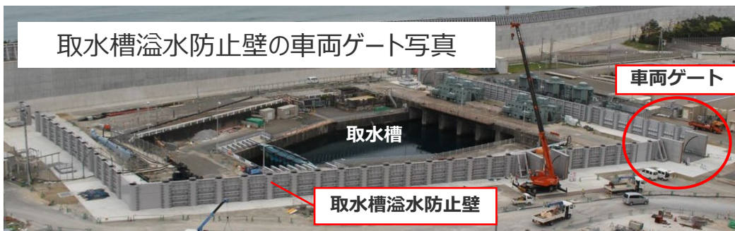
取水槽溢水防止壁の車両ゲート写真
