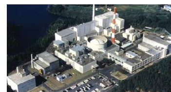
常陽：高速実験炉
