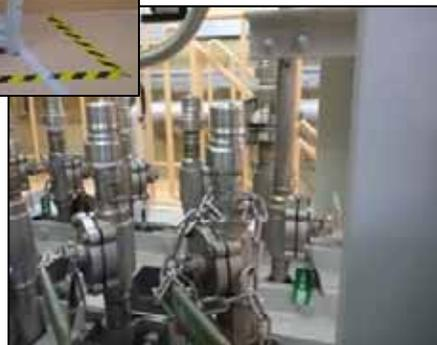
溶解槽に接続する配管 (接続口)
