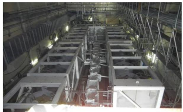
第9図 セシウム吸着装置の外観
