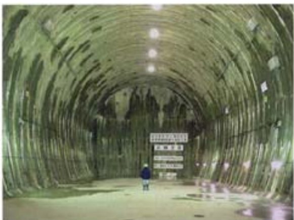
第6図 余裕深度処分の試験空洞写真 5)
