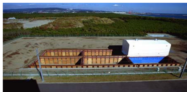
第10図 トレンチ処分実地試験施設(日本原子力研究開発機構・茨城県東海村) 7)
