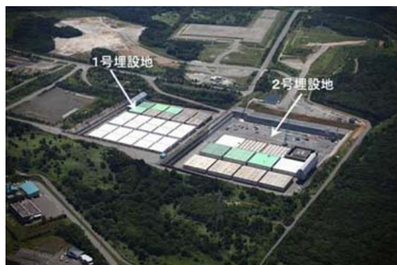
第8図 日本原燃(株)低レベル放射性廃棄物埋設センター(ピット処分・青森県六ヶ所村) 5)
