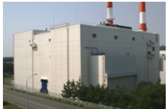
第6図 リサイクル機器試験施設の外観
