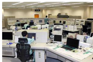
第12図 中央制御室
