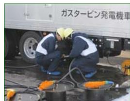
外部電源喪失時の電源車による給電訓練
