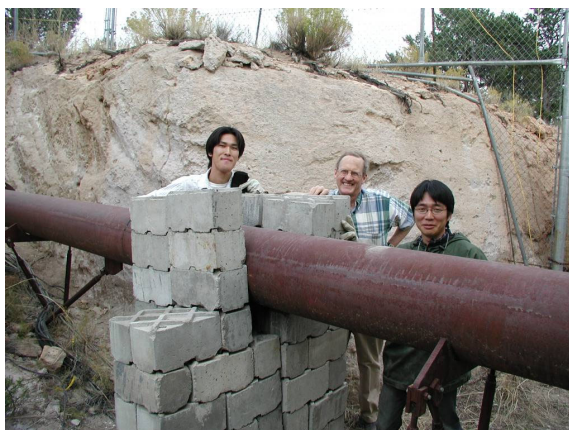
図 6 コンクリートブロックをビームダクトの周りに積んでいる途中の写真。
