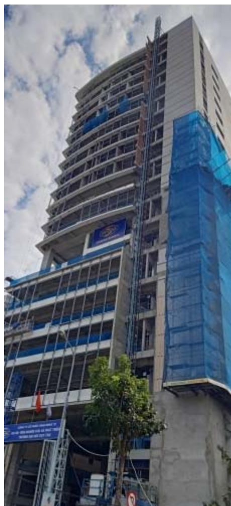
写真 10 建設中の DTU の新校舎
