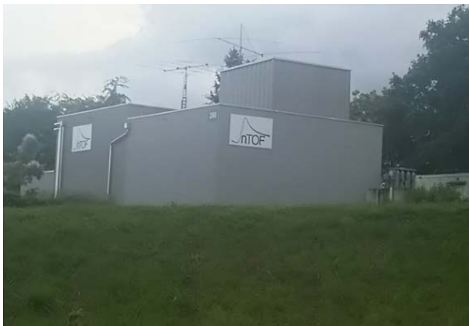
図 1 加速器トンネルの上にある EAR-2 の建物。
